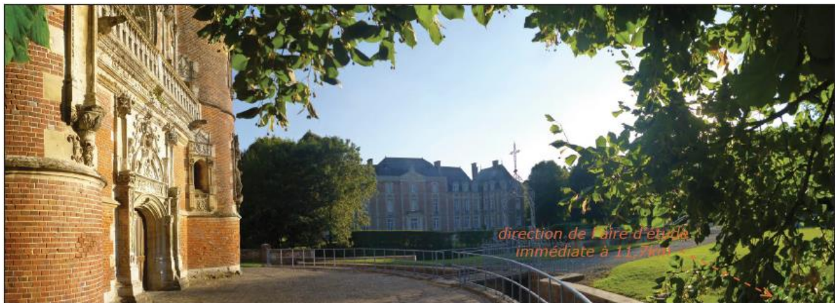
Figure 81 : Vue 38- Vue sur l'église de Tilloloy, facade du château à l'arrière-plan.
