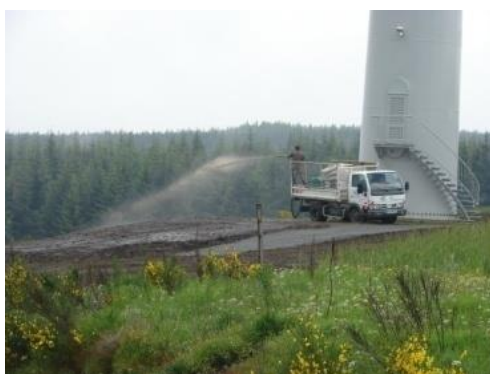
Revégétalisation par la technique d'hydroseeding
