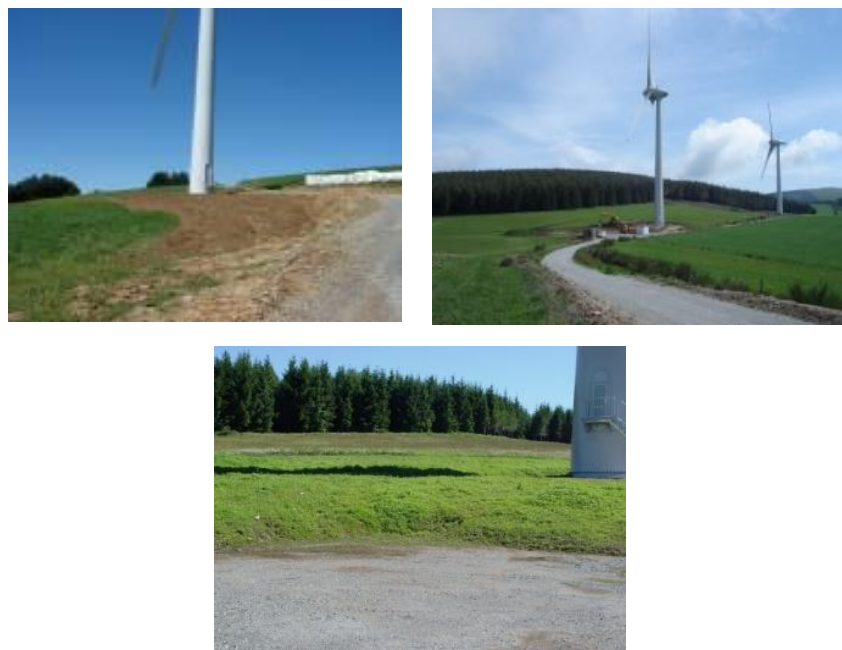
Figure 160 : Remodelage et revégétalisation des plateformes
