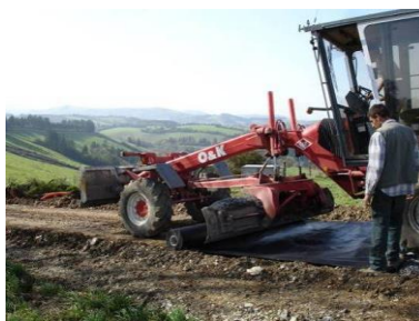
Pose du géotextile
