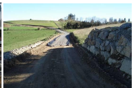
Mise en place du gravier
