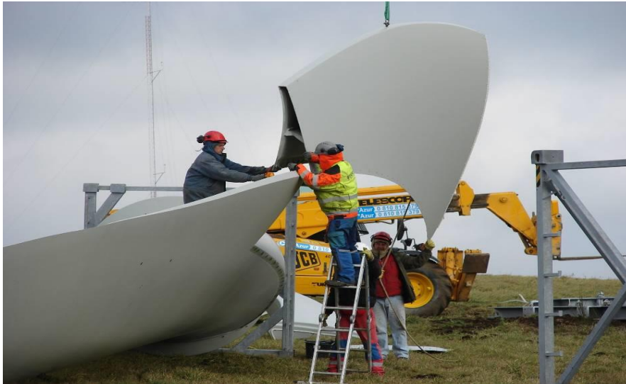
Ouvriers en phase de chantier
