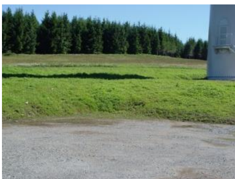
Reprise de la végétation aux abords des plateformes
