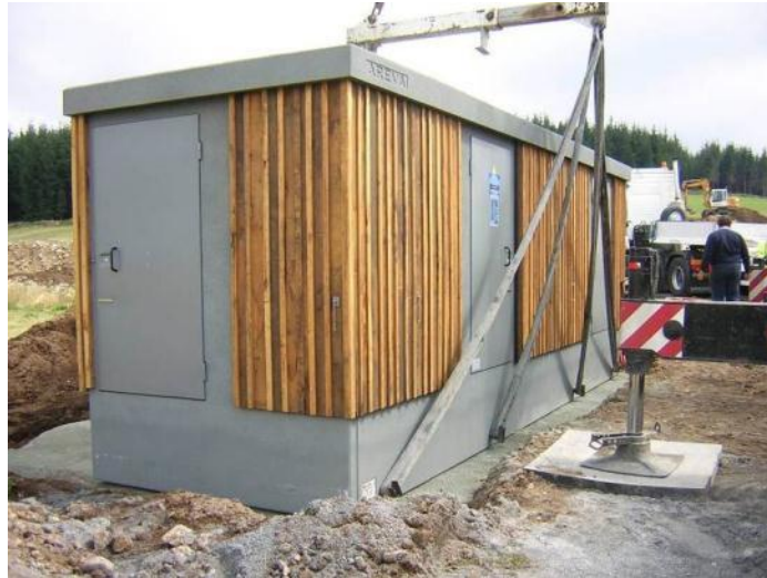
Photo 1 : installation d'un poste de livraison
