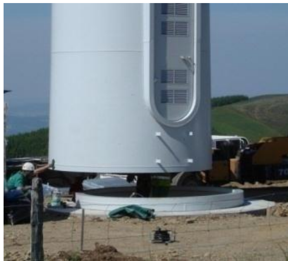
Figure 147 : Installation du mât sur la fondation
