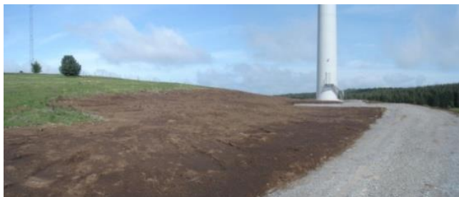
Remodelage des abords des éoliennes
