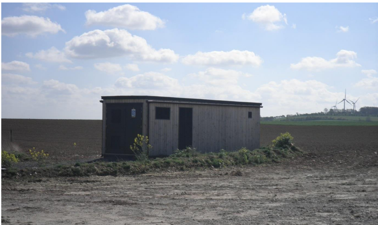
Poste de livraison du parc éolien de la vallée de l'Aa
