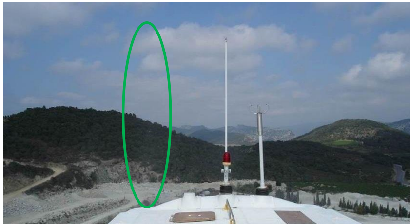
Figure 164 : Paratonnerre présent sur une éolienne de VALECO
